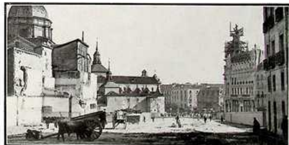
Los derribos vistos desde la calle de la Reina PHOT. S. M., PHOT. GARCÍA
