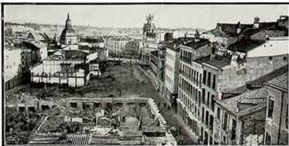
Las obras de la Gran Vía vistas desde la calle de Hortaleza
